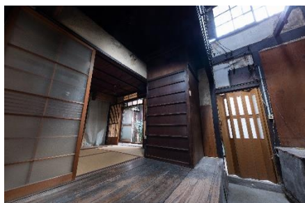
改装前の町家内観
